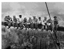
Fotografia de: Charles C. Ebbets Operários a almoçar nas alturas durante a construção do edifício RCA no Rockefeller Center (EUA, 1932)
